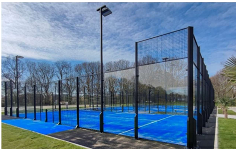
Padelbaan op een SuperSub® fundatie
